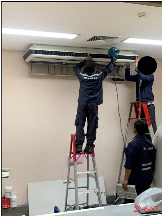
ล้างเครื่องปรับอากาศภายในอาคาร
